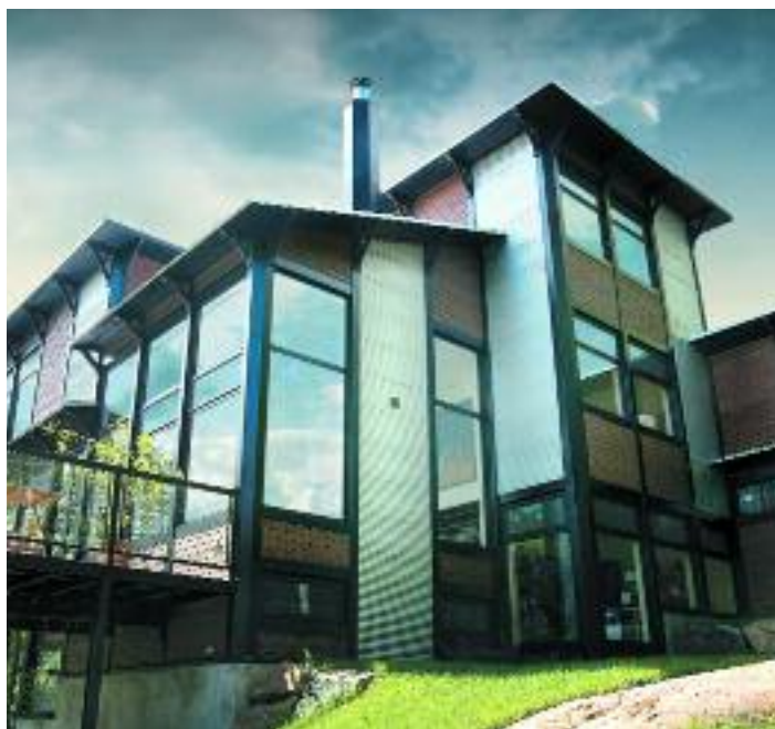
Le système de construction BONE Structure en acier léger s'assemble comme un jeu de Meccano: zéro clou, zéro mur porteur, zéro déchet.
