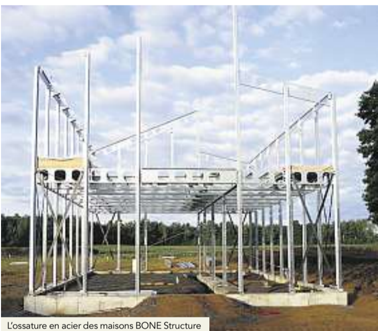
L'ossature en acier des maisons BONE Structure
