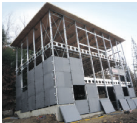
Les maisons à charpente d'acier Bone Structure, de la PME Simple Concept, sont conçues pour être montées à la main. [Photo : Simple Concept]
